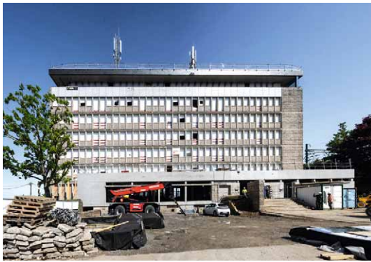
Le chantier du Totem comprend des heures d'insertion.
