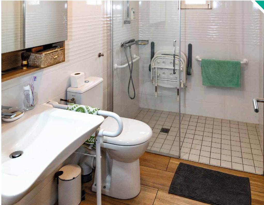
Adaptation d'une salle de bains pour permettre l'accès aux personnes à mobilité réduite.
