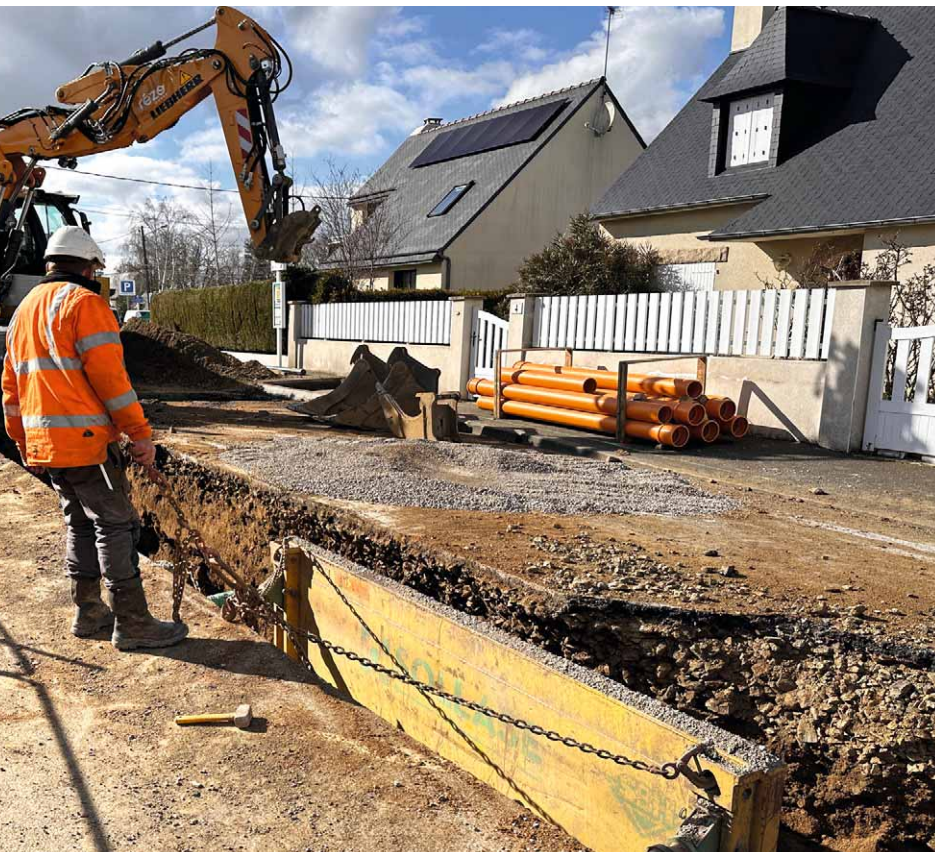
Le marché de renouvellement des réseaux d'assainissement permet de générer plus de 14 000 heures d'insertion.
